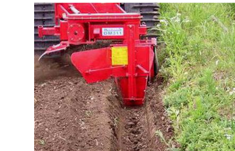
トレンチャーによる額縁排水溝の設置
